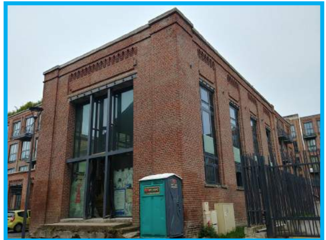
La Chaufferie, nouveau bureau de HAUTE FIDÉLITÉ à Lille-Hellemmes
